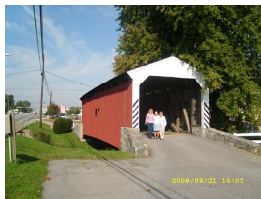
En överbyggd bro
